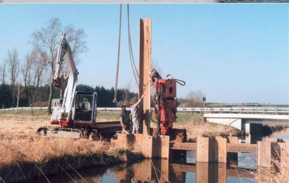
Neubau des Kanalschweires 2002
